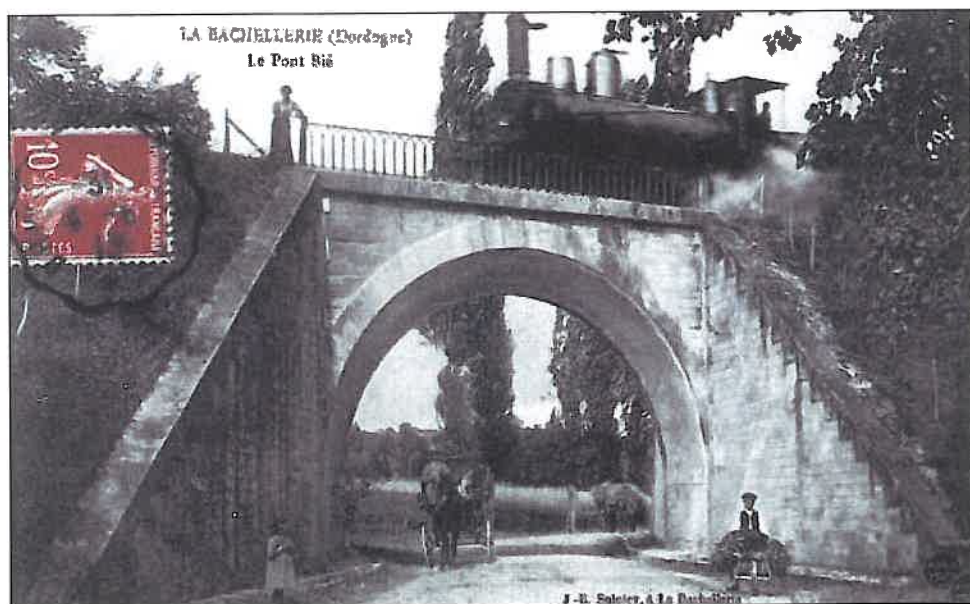
Fig. 5 : La 121 franchit le pont « Bié » de la Bachellerie
