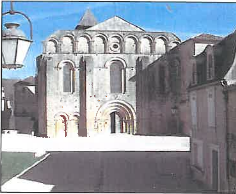
Fig. 1 - La façade de l'abbatiale de Cadouin
